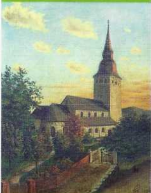
Bau des Querschiffes und des Chors der Pfarrkirche St. Johannes
