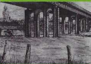
Bau der Erkrather Autobahnbrücke
