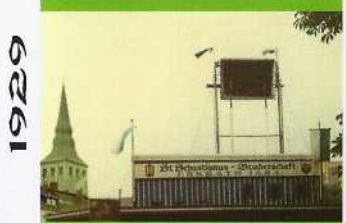
Bau des Schießstandes am Marktplatz
