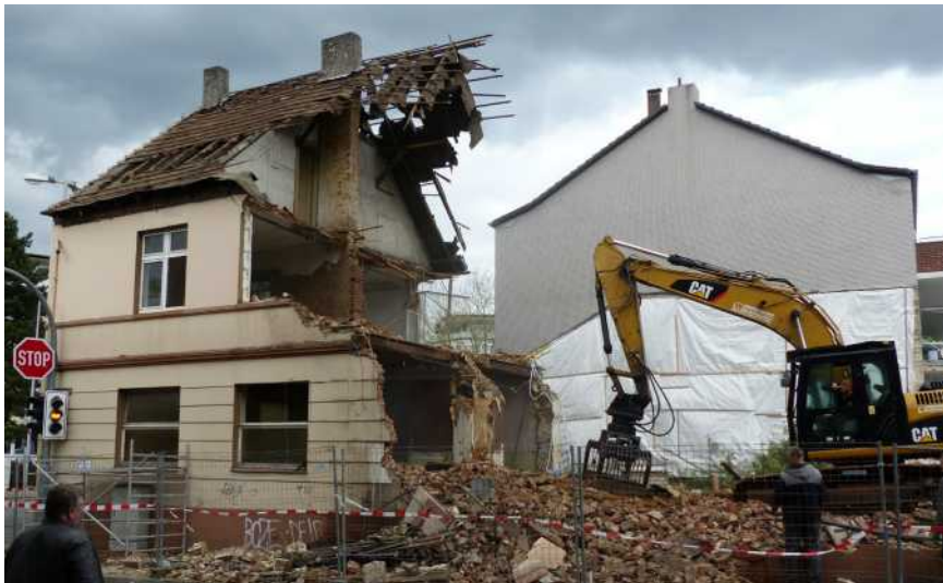
Abrissarbeiten am Weidenhof
