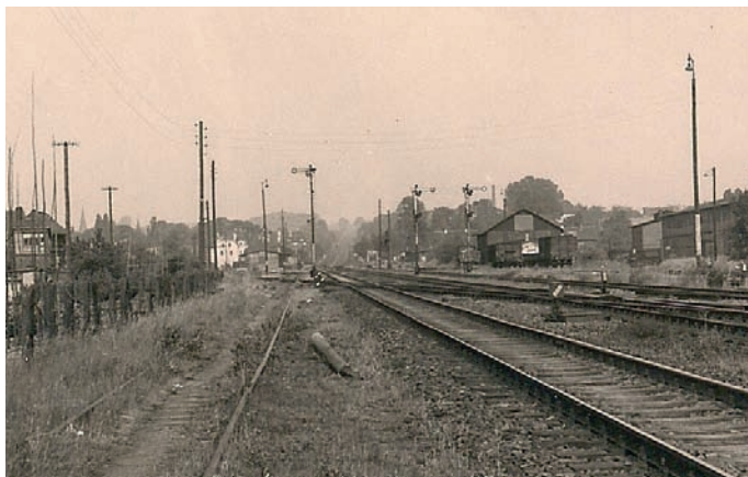
Bahnhof Erkrath mit den Produktionshallen der Firma Längen
