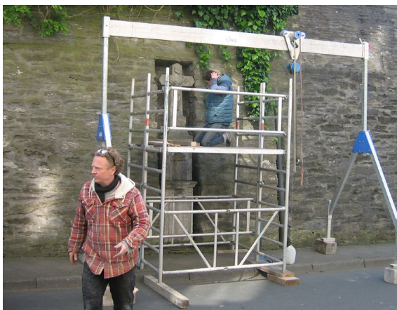
Demontage im Mai 2022
